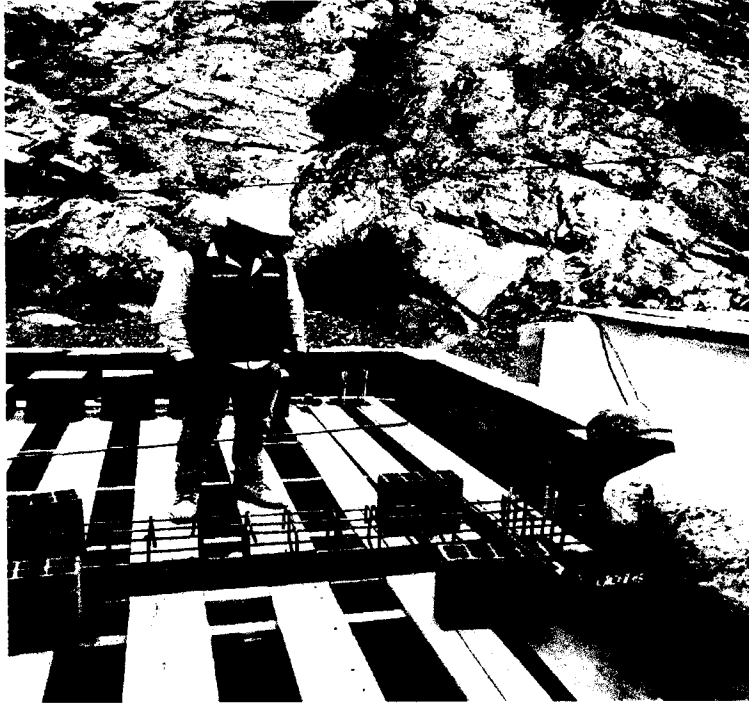
SE OBSERVA LA UBICACIÓN DE VIGAS DE LA CASETA
