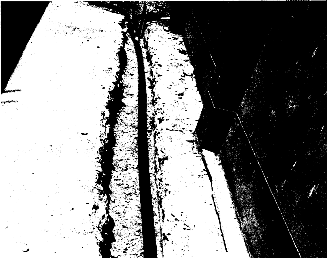
INSTALACION DE TUBERIA HDPE63 mm
